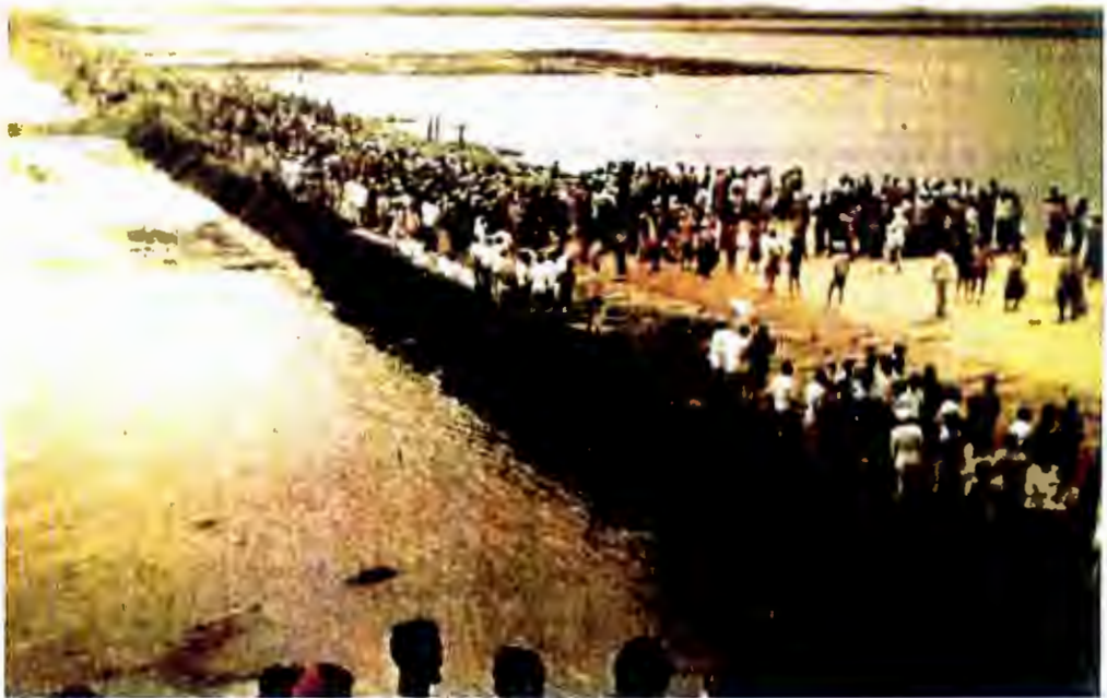
Photo 2.2.: Construction de digues (Bengladesh)
